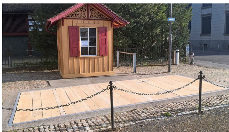
Die Last wird auf der Waageplattform, genannt Brücke, platziert. Foto: PD
